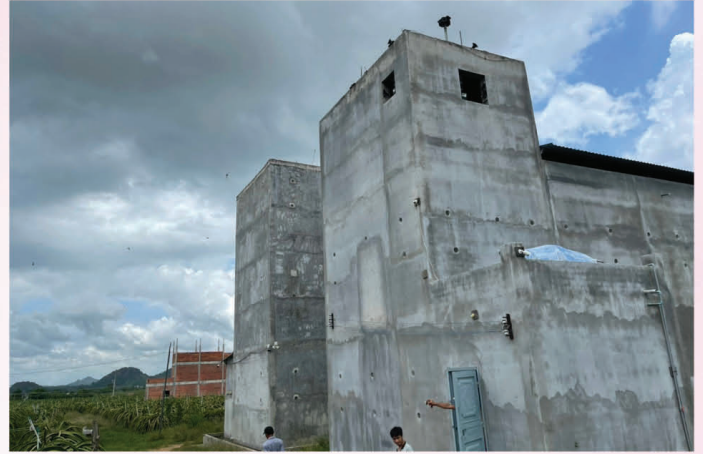
Một Nhà yến trên địa bàn huyện Hàm Thuận Bắc, tỉnh Bình Thuận
